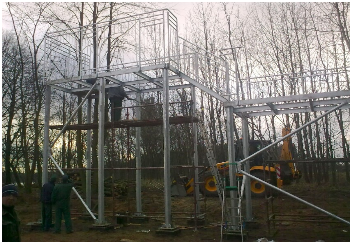
9. KONSTRUKCJA PLATFORMY POD ZESPÓŁ ZJEŹDŹALNI WYSOKICH PW-1
