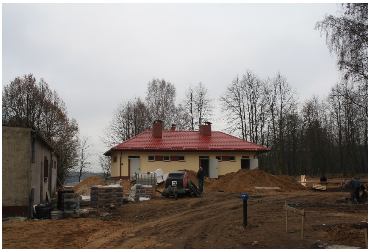
7. BUDYNEK SANITARNY Z PRZEBIERALNIĄ[NR 3]
