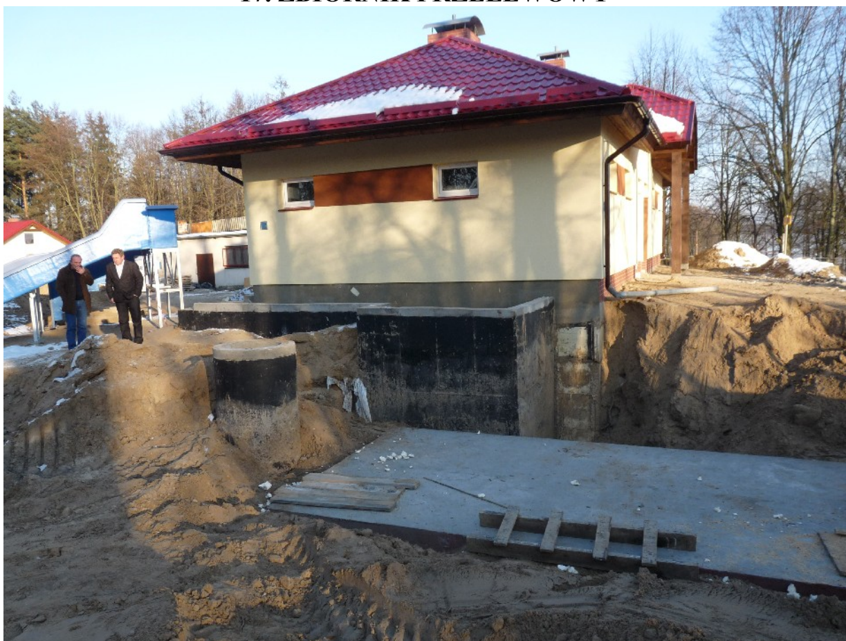
18. ZBIORNIK PRZELEWOWY. STUDNIA DRENAŻOWA
