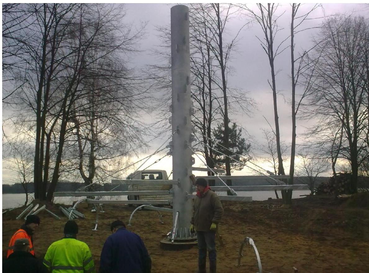
12. KONSTRUKCJA PLATFORMY POD ZESPÓŁ ZJEŹDŹALNI WYSOKICH PW-1
