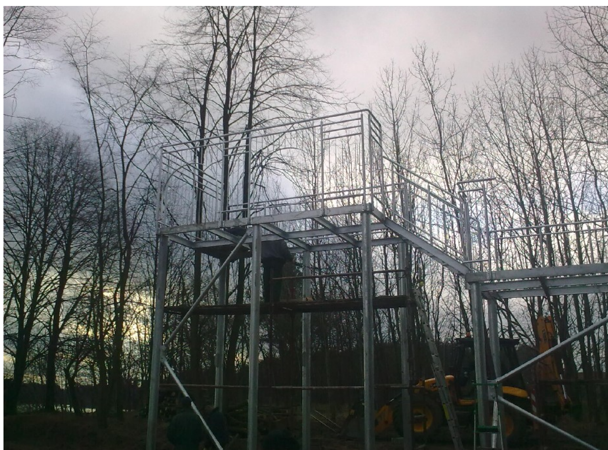
10. KONSTRUKCJA PLATFORMY POD ZESPÓŁ ZJEŹDŹALNI WYSOKICH PW-1
