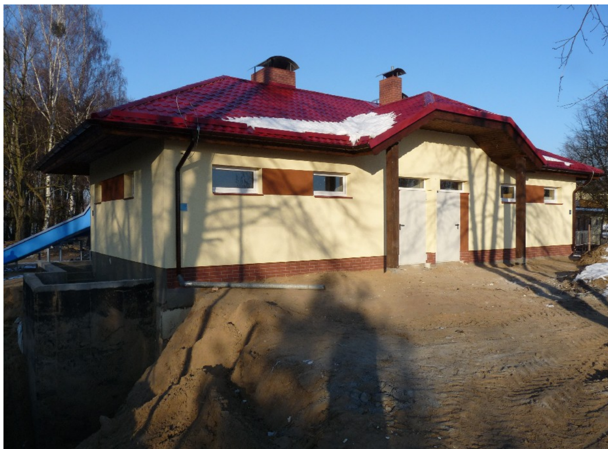
8. BUDYNEK SANITARNY Z PRZEBIERALNIĄ[NR 3]
