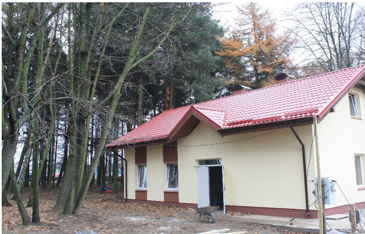
5. BUDYNEK SANITARNY Z PRZEBIERALNIĄ [ NR 3]
