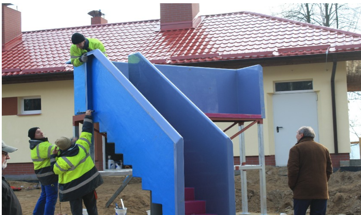
15. ZJEŹDŹALNIA WODNA „3W1” PW-3 KONSTRUKCJA SCHODÓW
