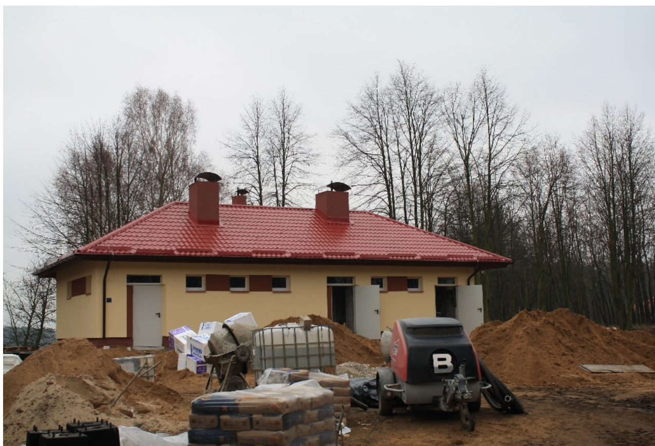
6. BUDYNEK SANITARNY Z PRZEBIERALNIĄ [NR 3]
