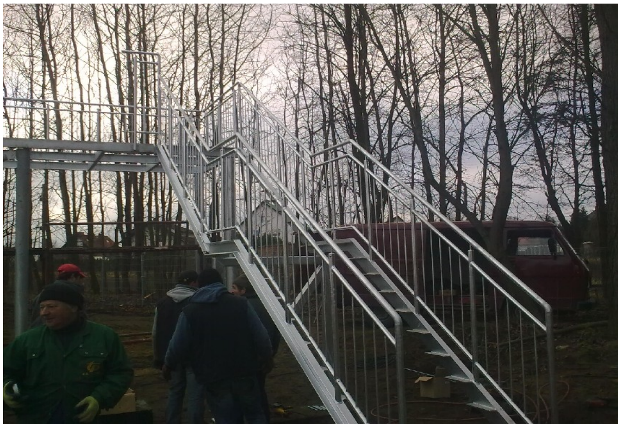
11. KONSTRUKCJA PLATFORMY POD ZESPÓŁ ZJEŹDŹALNI WYSOKICH PW-1
