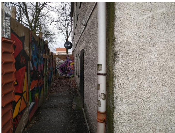
Zdj. 2. Elewacja północno-zachodnia
