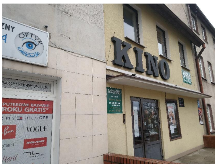
Zdj. 1. Elewacja południowo-wschodnia
