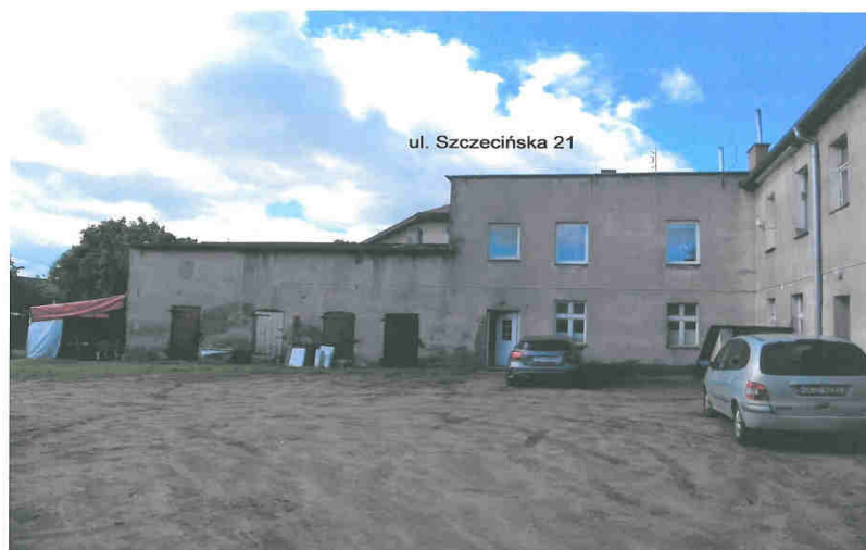
Budynek Szczecińska 21 - widok od strony podwórza
