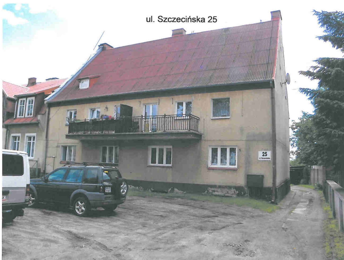
Budynek Szczecińska 25 od strony podwórza
