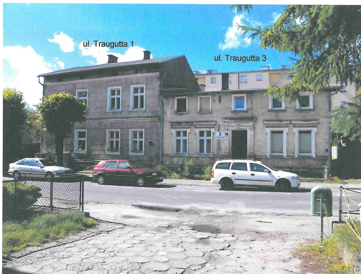
Budynki Traugutta 1 i Traugutta 3 widok od frontu
