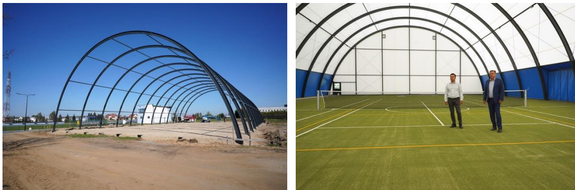
Fot. 5 i 6. Boisko wielofunkcyjne podczas wykonywania i po zakończeniu prac.
