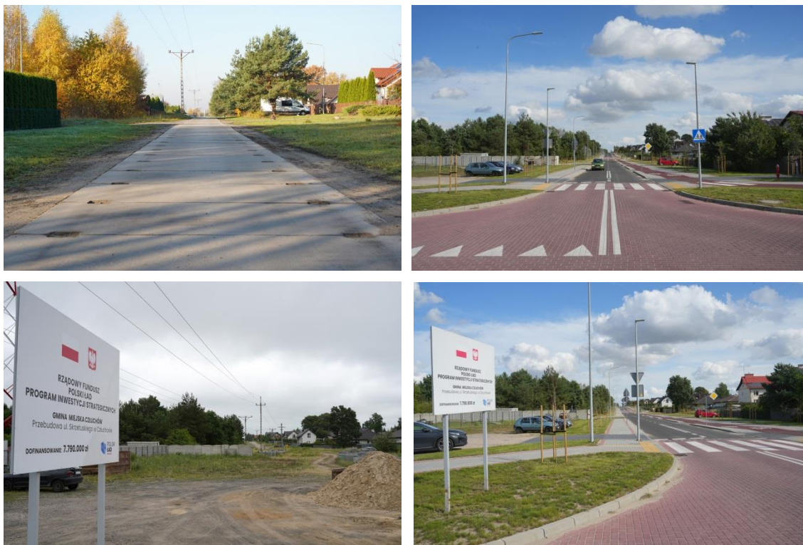
Fot. 1, 2, 3 i 4. Ulica Skrzetuskiego przed, w trakcie i po przebudowie.
